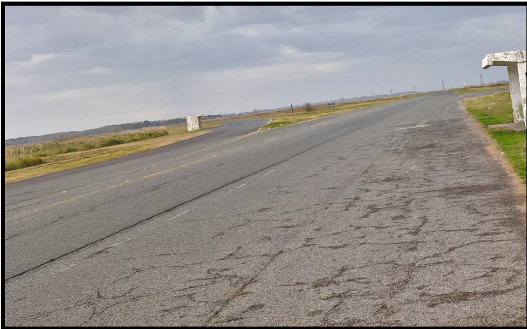
Figura 259 - Grietas y roturas en RP 11
