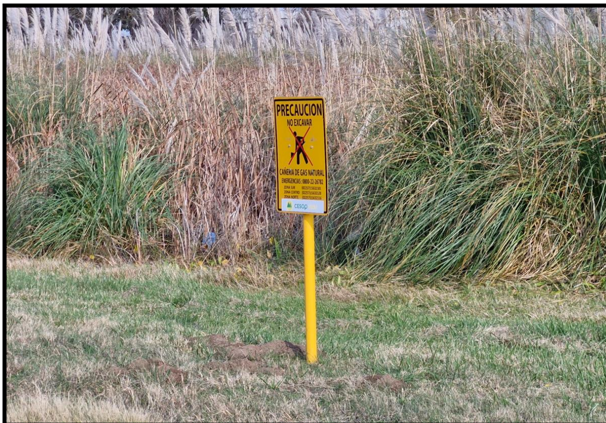
Figura 88 - Cartel de precaución “No excavar” por cañería de gas natural (36°43'25.45"S; 56°42'15.67"O)
