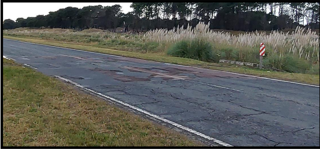
Figura 258 - Grietas y roturas en RP 11
